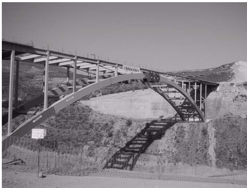
Estructura metálica del puente ya montada.
