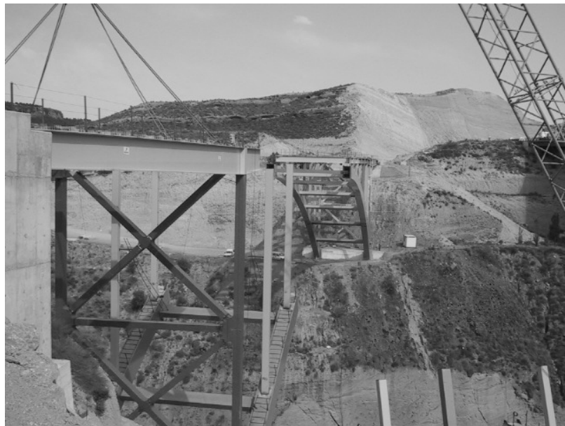
Colocación de piezas del tablero. Al fondo un voladizo ya construido.
