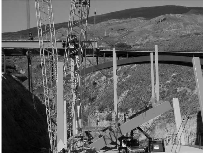
Colocación de la primera diagonal.
